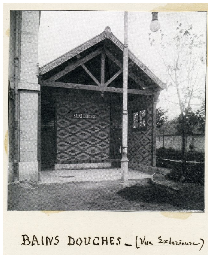
Doc 4: vue extérieure des bains douches pour les femmes
